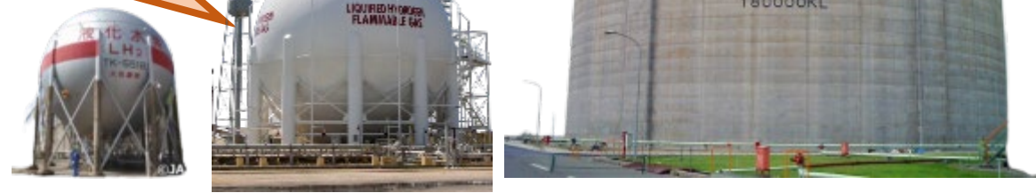
種子島宇宙センタ 容量540m 3 NASA Kennedy Space Center 容量3,218m 3 平底円筒型 容量50,000m 3 以上が望ましい
